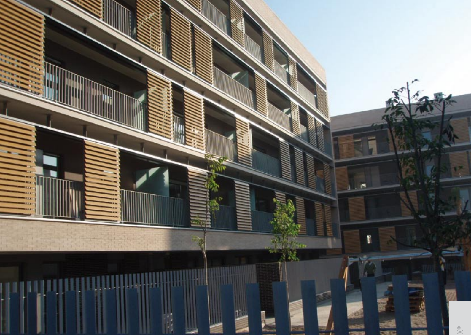
Instalación Alufix® Baq corredera en comunidad de viviendas.
