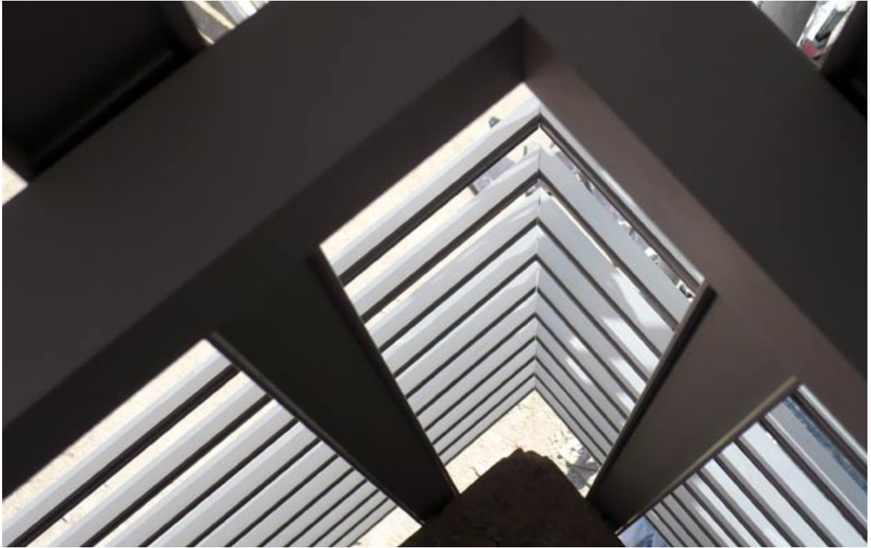
Detalle vista interior Alufix® corner en balcón edificio viviendas.
