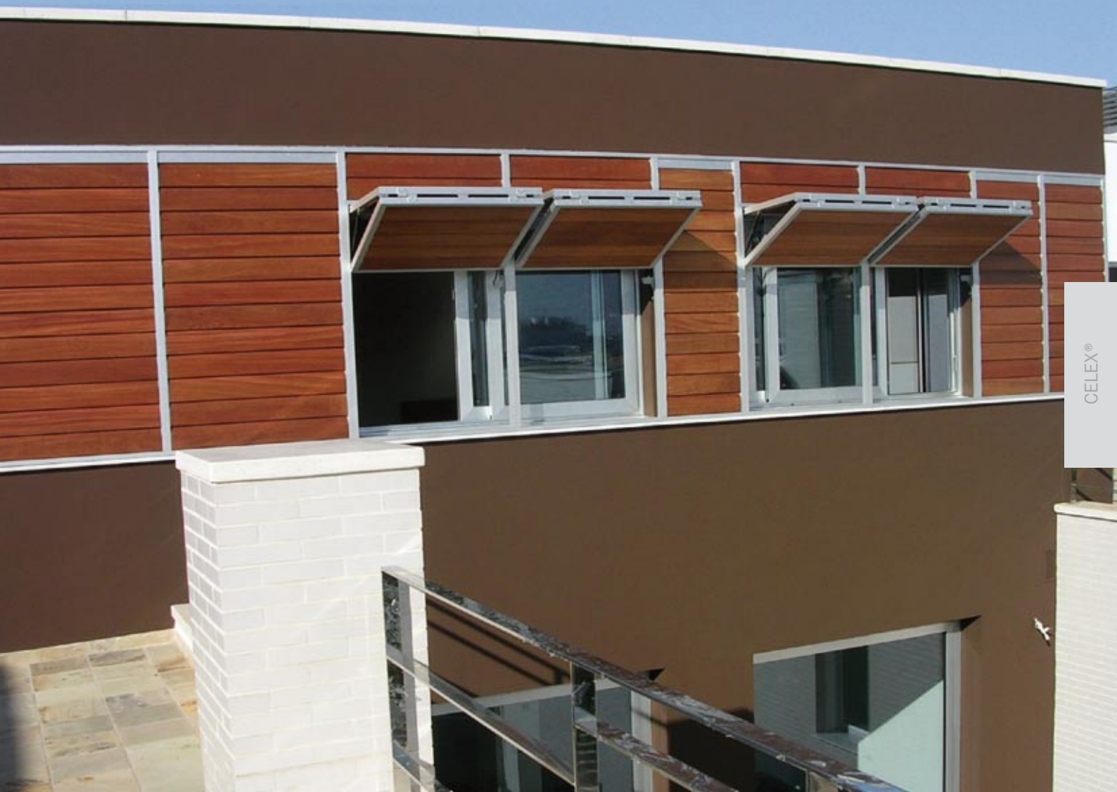
Fachada lateral vivienda unifamiliar con Woodcelex® con marco corrugable "a techo".
