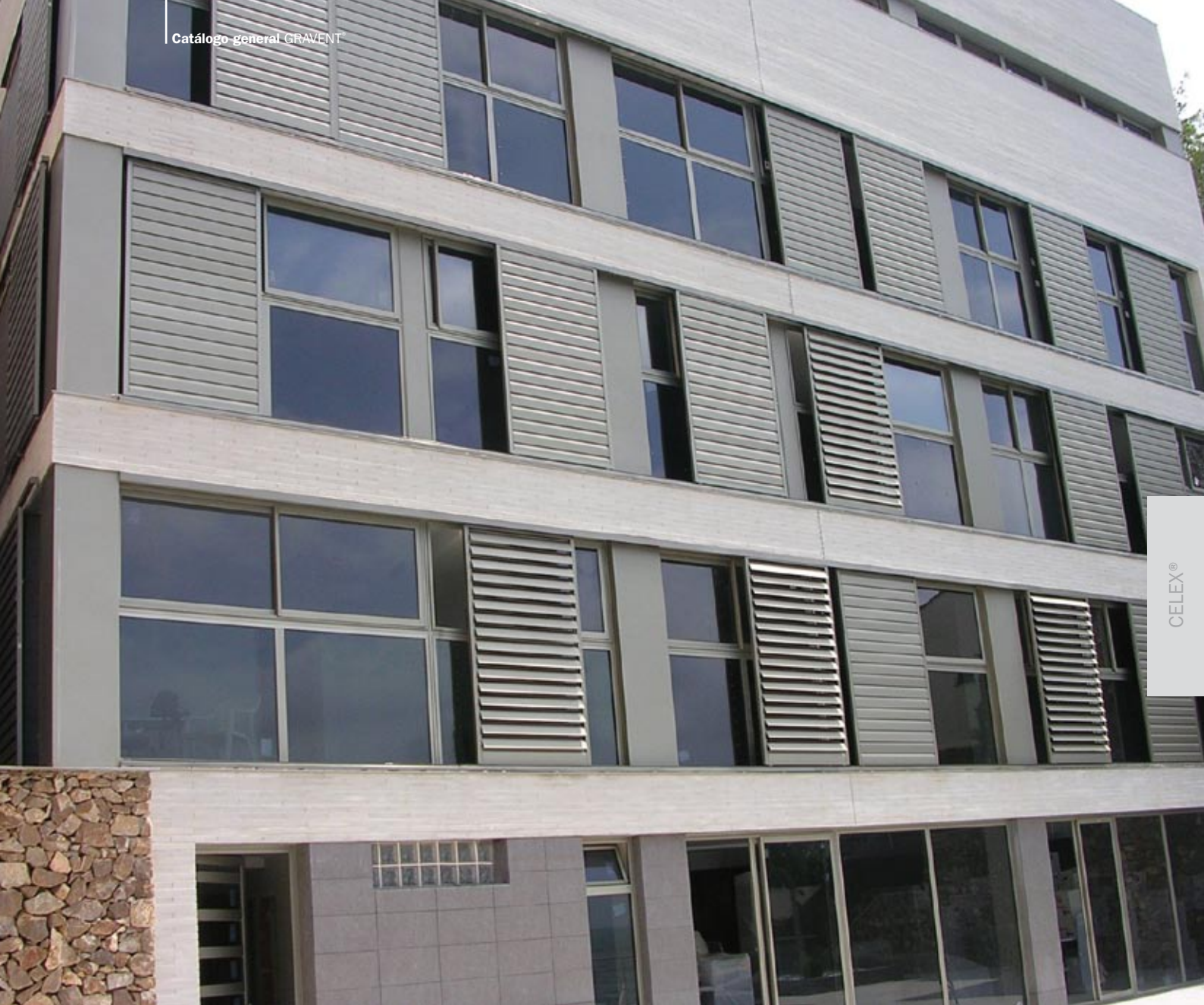
Instalación Alucelex® con marco corredero con tapagüías en edificio de apartamentos
