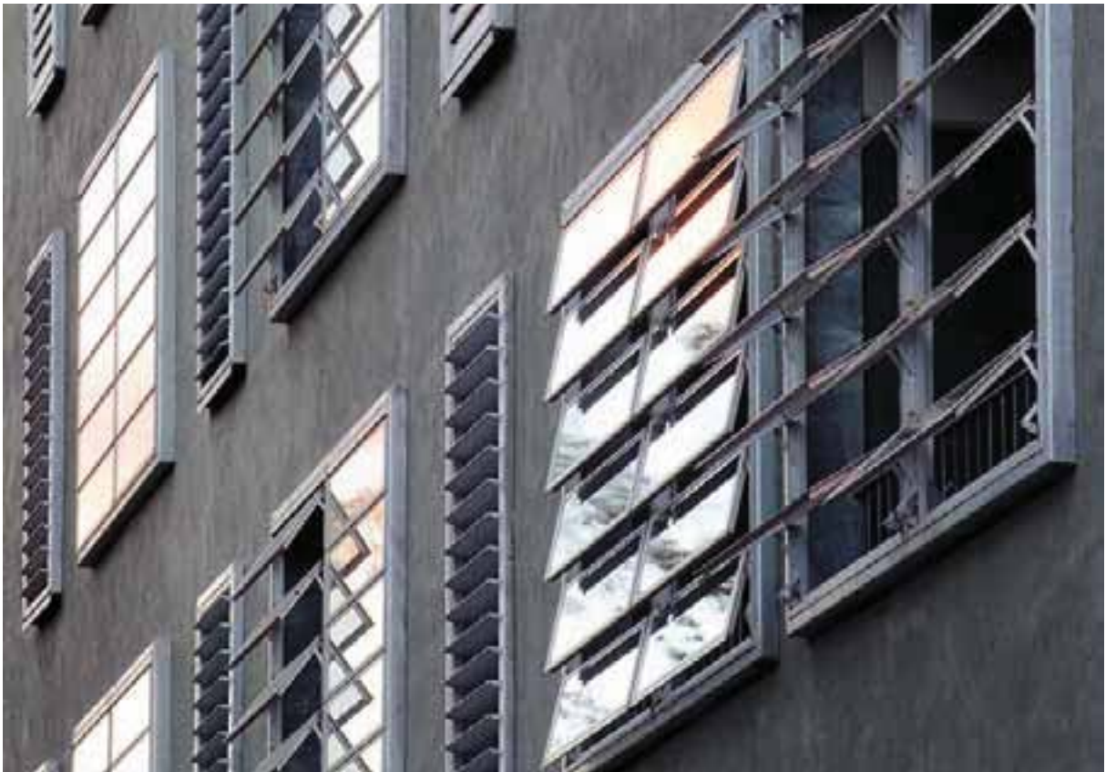
Ventanas Hervent instaladas en edificio de viviendas.
