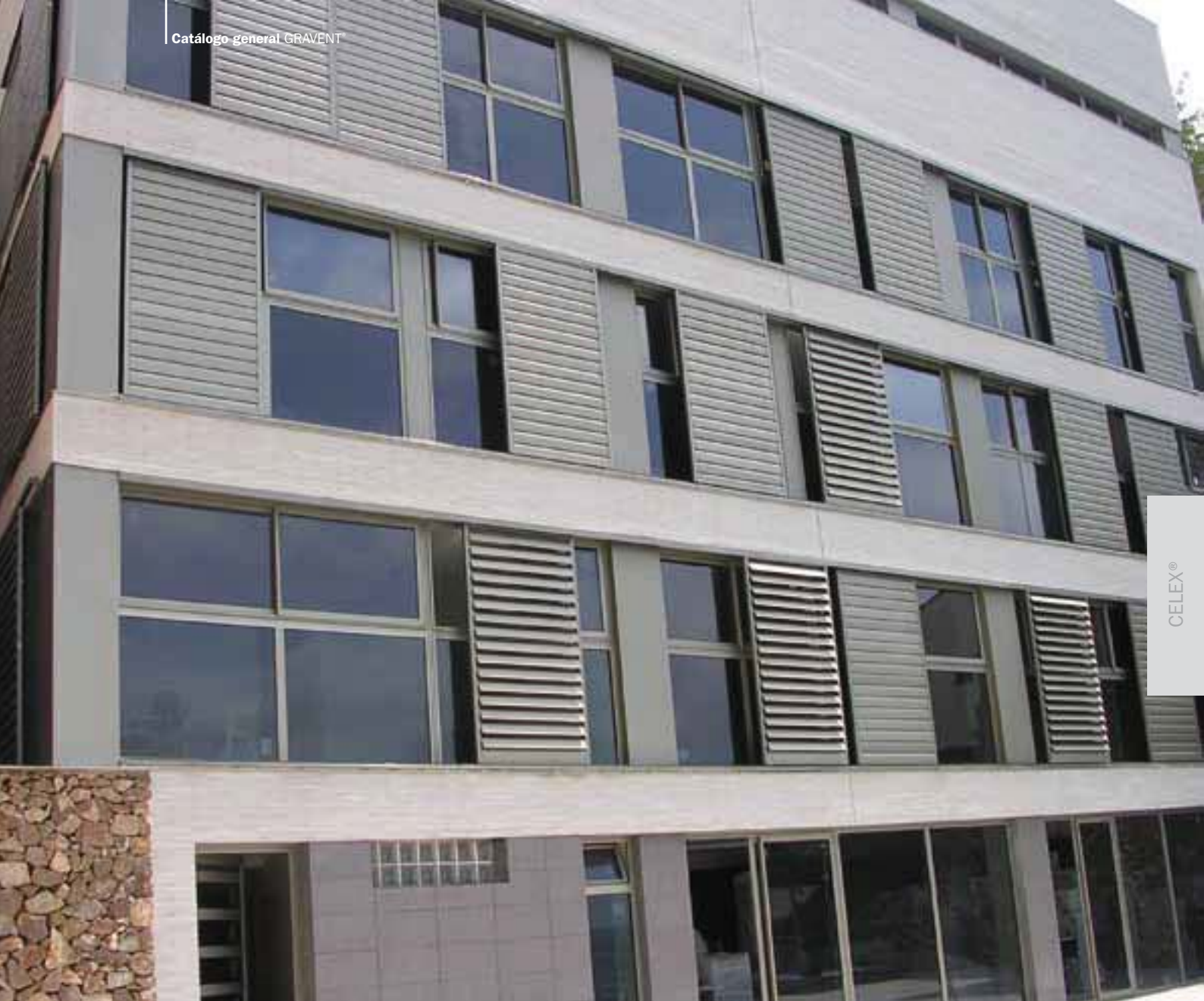
Instalación Alucelex® con marco corredero con tapaguías en edificio de apartamentos
