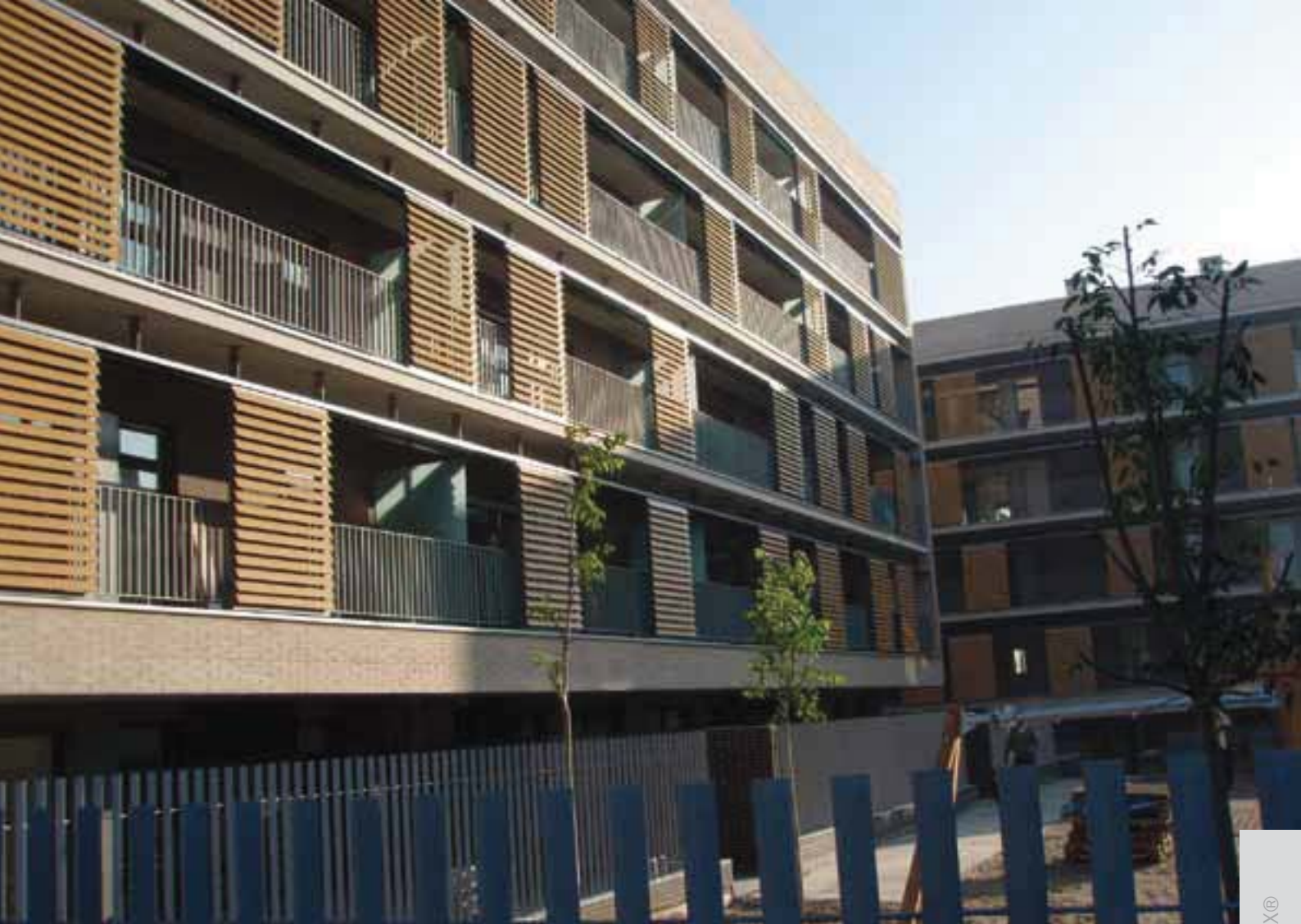
Instalación Alufix®Baq corredera en comunidad de viviendas.
